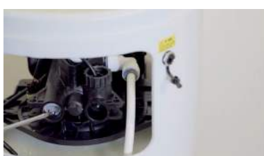
Sostituzione gomiti mandata salamoia
