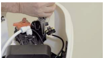
Sostituzione filtro ingresso acqua
