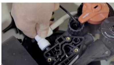
Sostituzione gomiti mandata salamoia
