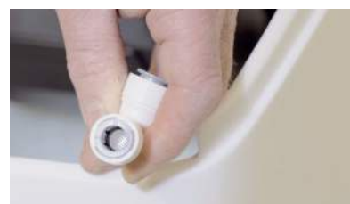
Sostituzione gomiti scarico salamoia
